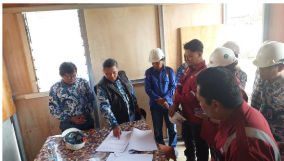
Foto 1. Inspeksi Lapangan dan Koordinasi Pembangunan Gedung Radar S Band Cilacap
