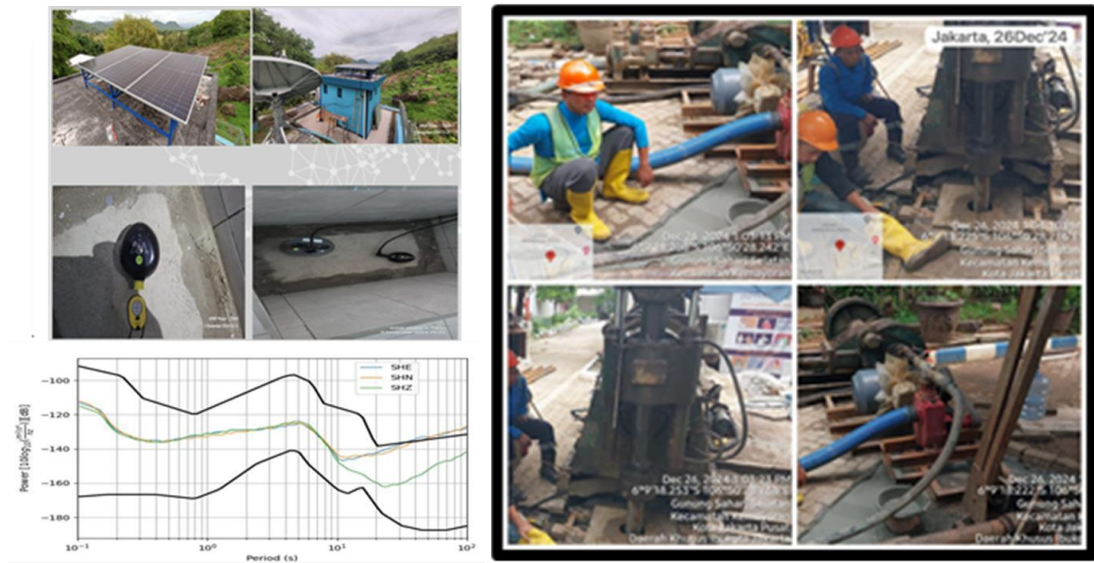
Gambar 6. Proses Pemasangan Seismograf
