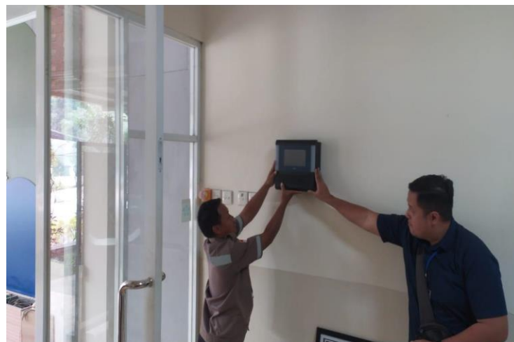
Gambar 46. Survei dan instalasi pemasangan display warning
