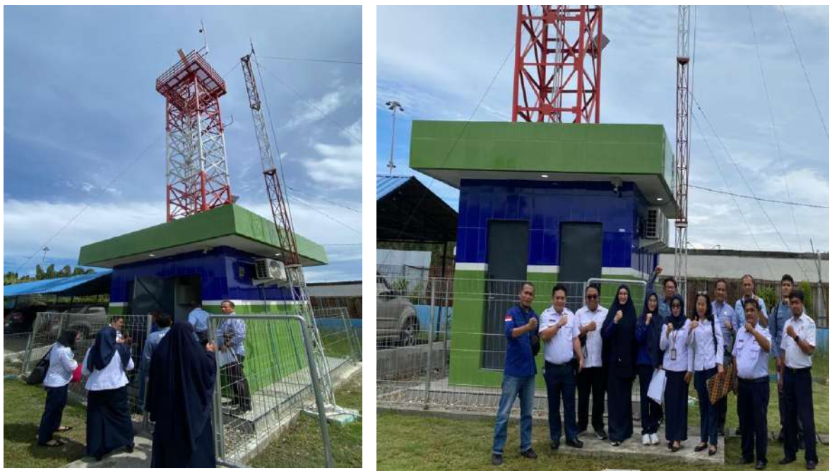
Gambar 3.22 Pembangunan Radar Maritim di Stasiun Maritim Belawan
