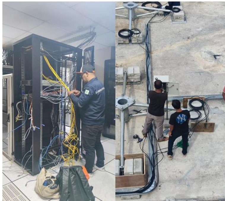
Gambar 12. Proses migrasi server dan antenna dari Gedung C ke Gedung D
